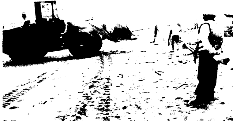
Foto 25: Supervisión constante en obras de tierra en traslado de tuberías de emisor
