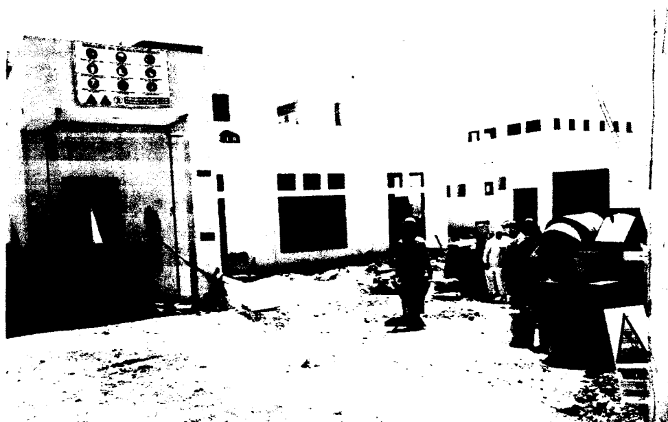
Foto 7: Señalización de información general en la entrada de la Obra
