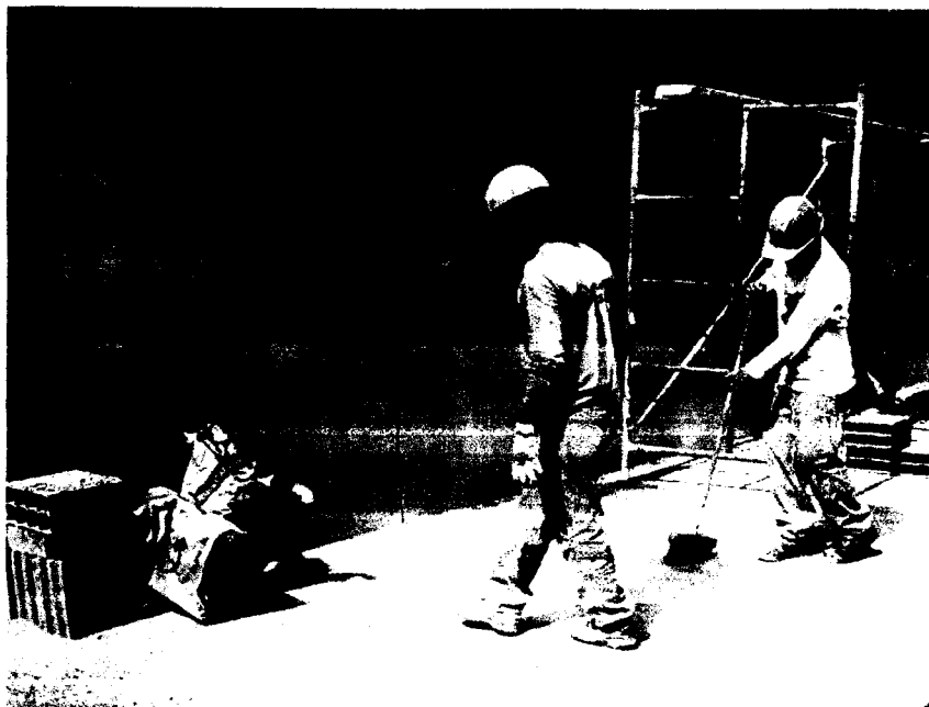
Foto 18: Orden y limpieza en las áreas de las obras
