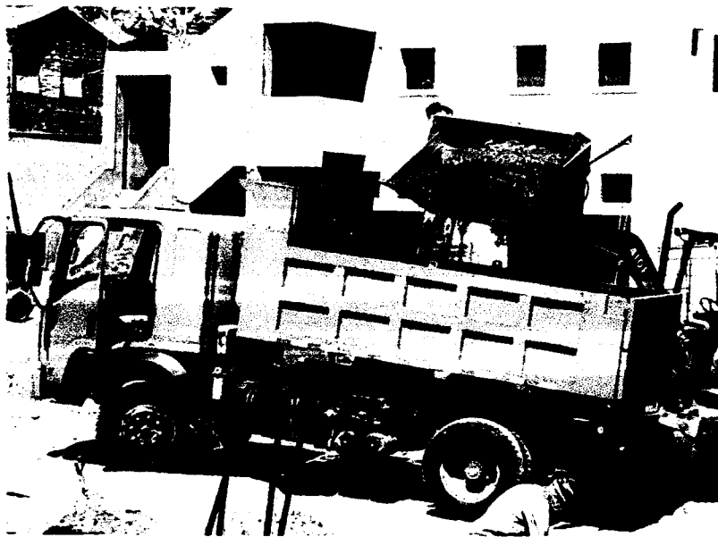
Foto 16: Limpieza de los residuos almacenados, para luego ser evacuados en volquetes a las zonas de botadero
