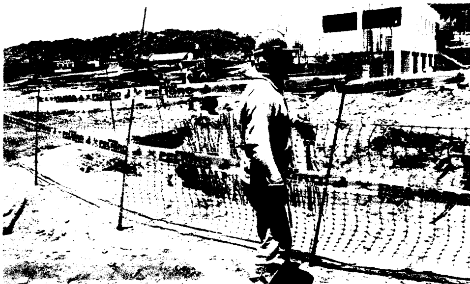
Foto 8: señalización en trabajos en el exterior de la obra
