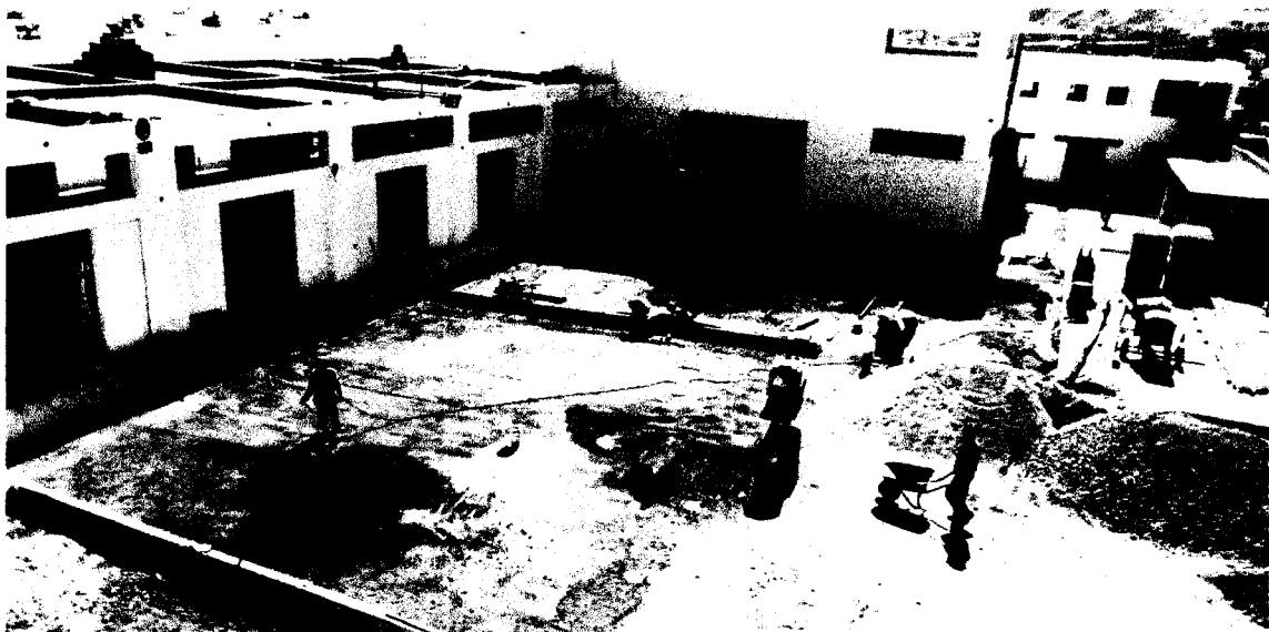
FOTO N° 02: Relleno y compactación de base, patio de maniobras.
