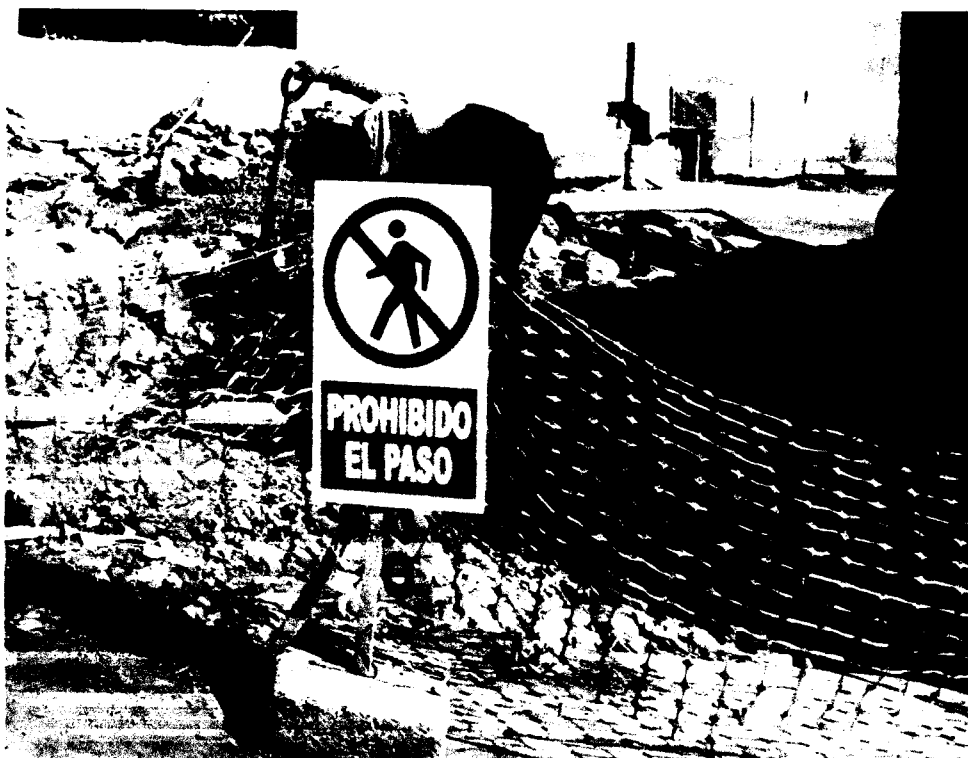
FOTO 9: Delimitación de las zonas de trabajo con cinta de seguridad y cachacos de concreto
